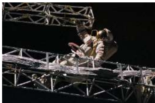
Активные монтажные работы в открытом космосе
